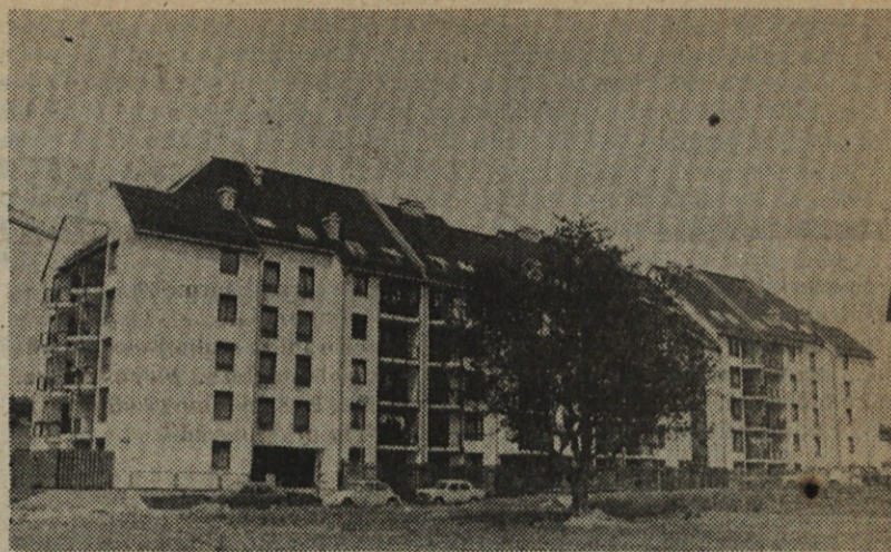
Prvi bloki v soseski Rabelčja vas, ki so jih začeli graditi junija 1981 leta so že vseljeni
