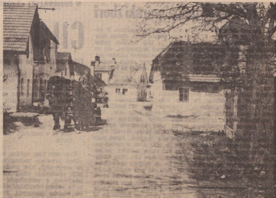
ASFALT TUDI V TOMAČEVEM — Od Savske ceste skozi Tomačevo in Stožice do Titove ceste je zdaj sklenjen asfaltni krog.
