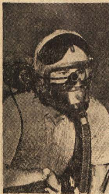
George Davis, poskusni pilot ne-ke ameriške letalske tovarne, ima na sebi pilotsko masko za višin-ske polete, nanjo pa je pritrjena posebna kamera, s katero naj bi snemal med poletom z veliko hitrostjo. Naprava med pilotovi-ni očmi služi za usmerjanje ka-mere, snemani objekti pa je mo-góče spremljati s premikanjem glave. Davis pravi, da je že pri prvem poskusu napravil jasne posnetke
