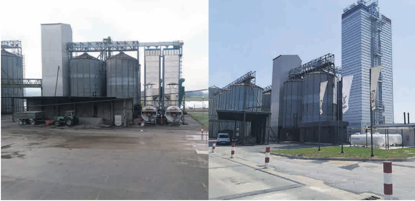
V Perutnini Ptuj so se obnove stare sušilnice lotili lani, letos je že prenovljena in pripravljena na odkup zrnja. Na fotografiji levo je stara sušilnica, desno pa nova.
