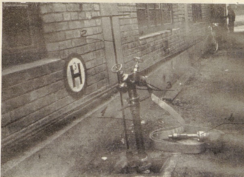
1 — hidrantni nastavek 3 — priključka z ventili
