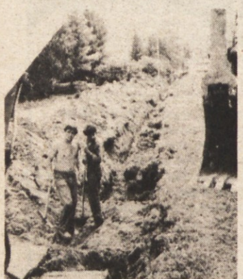
PREKOPANA METLIKA — Prejšnji teden so delavci črnomaljskega Goka začeli v Metliki kopati jarko za telefonsko kabelsko kanalizacijo. Skopali bodo okoli 3 kilometre jarkov in Metlika bo dva meseca bolj ali manj prekopana, v tem času bo delno oviran promet skozi mesto in tudi sicer bo treba malo potrpeti. (Foto: A. B.)
