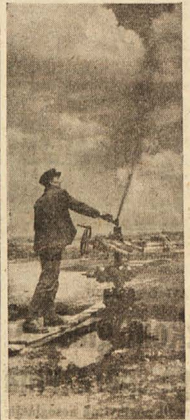
Ena izmed vrtn, pripravljena za eksploatacijo
