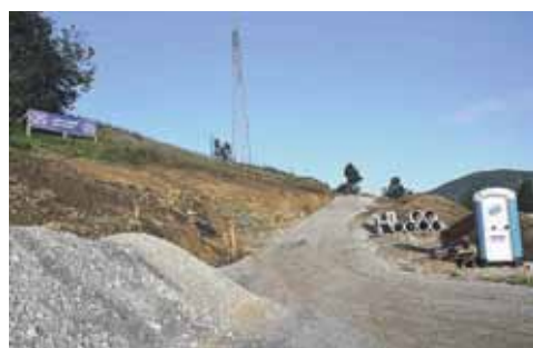
Urejanje dostopne ceste do OŠ Dobrova s priključkom na regionalno cesto je v polnem teku.
