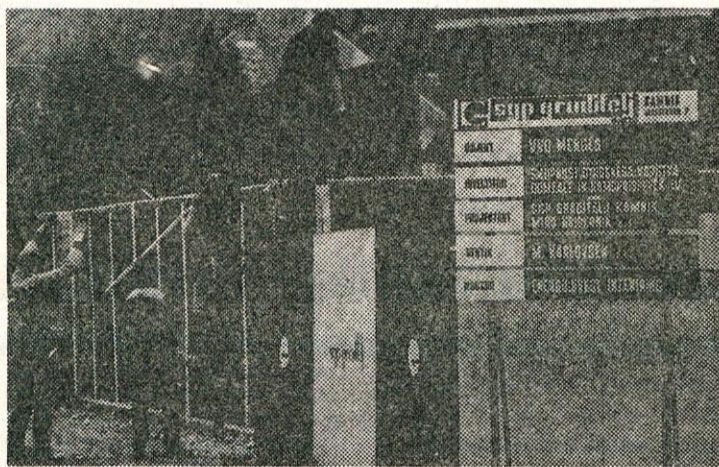
Pričetek gradnje vrtca v Mengšu.
