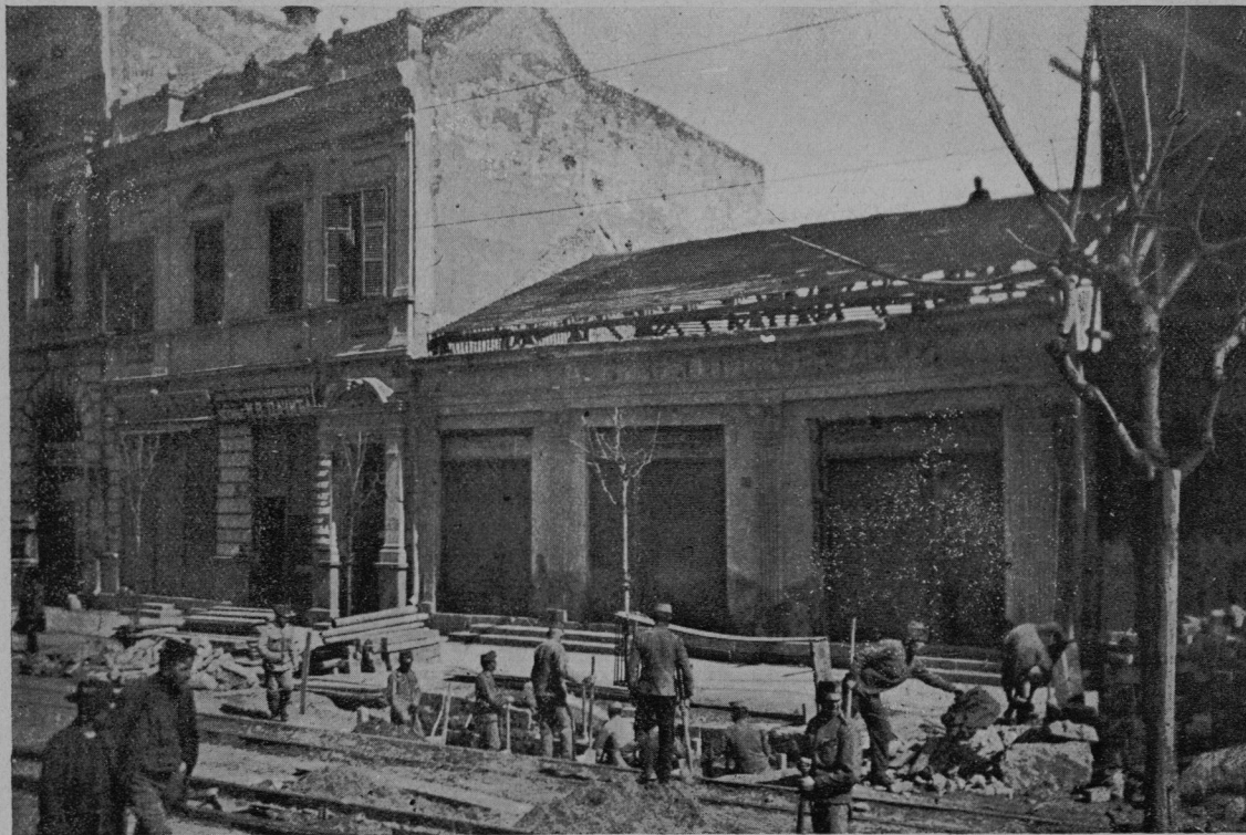
Iz razrušenega Belgrada: Naše vojaštvo popravlja mestno kanalizacijo.
