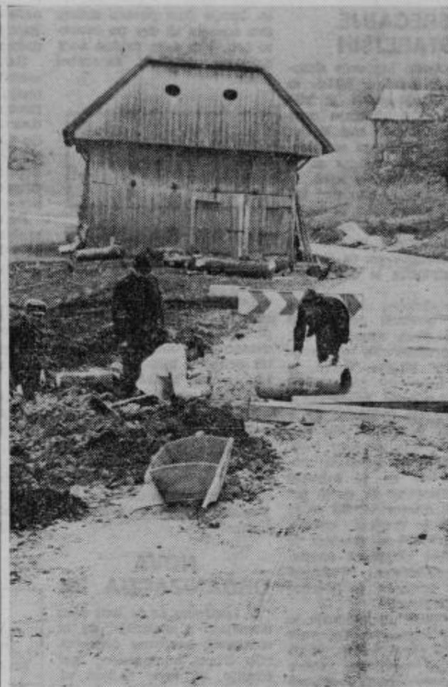
Takole so pričeli s spomladanskimi deli na cestah v Trški gorci pri Crnlici. Delavci celjskega Cestnega podjetja delajo vodni propust in luknjičasta cesta bo kmalu spet za nekaj časa urejena. Foto: D. Medved
