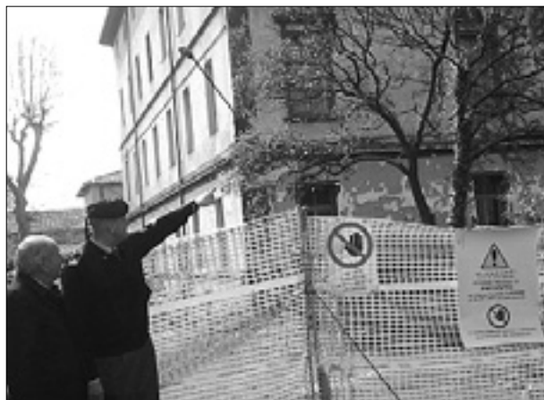
Poveljnik brigade in župan na gradbišču
