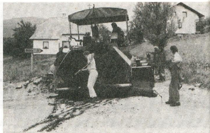
Zaključna asfalterna dela na cesti Moravče-Podbrdo. (foto MARJAN GRILJ)
