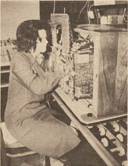
Smilja Rakić nastavlja električne parametre na barvnem televizorju.
