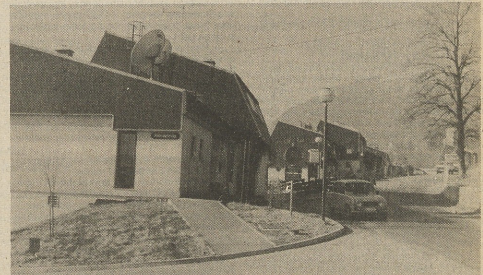
V Bovcu so bogatejši za kabelski sistem, ki omogoča spremljanje šestih satelitskih programov (dva bodo še dogradili), dveh zemeljskih ter UKV program in interni program v Kaninski vasi.
