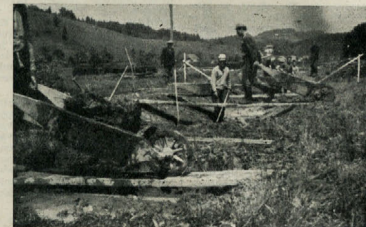
ZAČETNA DELA PRI MELIORACIJI ZEMLJIŠČ V KARLOVICI. Z MELIORACIJO BODO V TAMKAJŠNJIH KRAJIH PRIDOBILI PRECEJ NOVIH OBDELOVALNIH POVRŠIN
