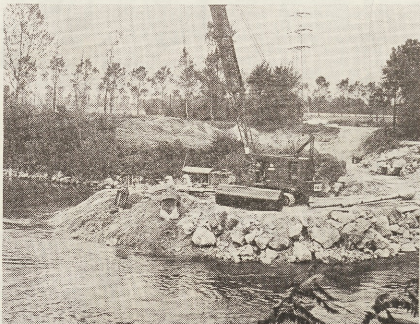
Betoniranje pilotov za novi Sentja-kobski most, ki ga bodo gradili naši delavci
