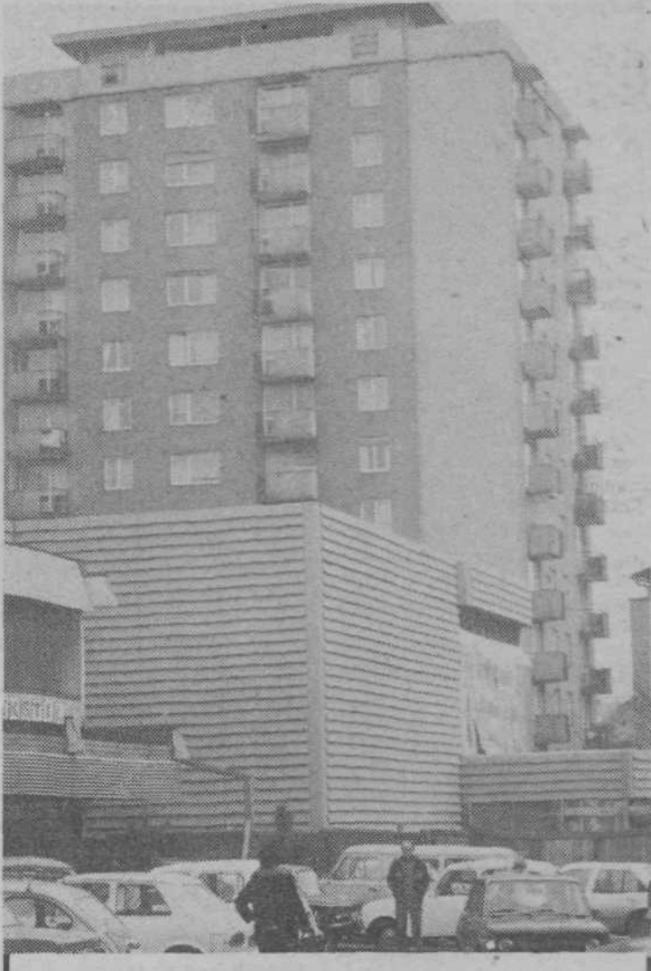
Dom španskih borcev se je že otrese gradbenega oklepa. Zunaj je dokončan in pospešeno urejajo tudi okolico. Seveda pa je najbolj živo v notranjosti doma. Delavci raznih poklicev hitijo, da bi bil Dom španskih borcev nared do občinskega praznika. Občinski sekretariat za občno upravo, proračun in skupne zadeve zagotavlja s svojimi delavci vsa dela v zvezi z upravljanjem doma, dokler le-ta ne prične redno funkcionirati.
