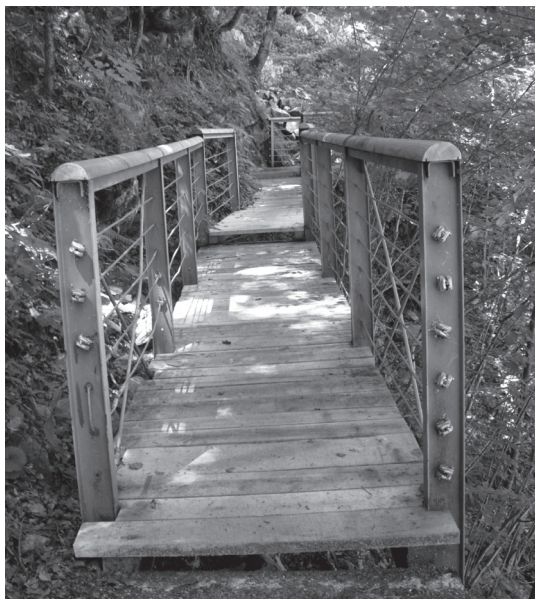
Slika 12: Konzolni mostički po obnovi leta 2013
