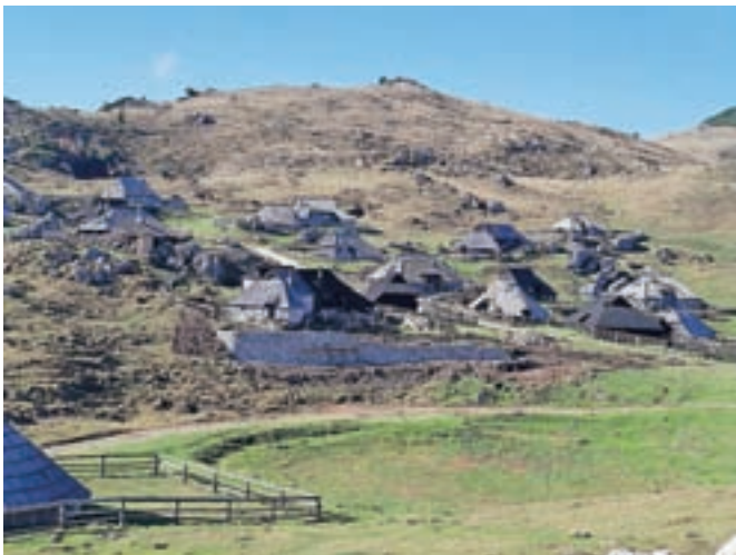
Ali je novozgrajeni podporni zid na Veliki planini skladen s pravili, bo ugotavljala inšpekcija. / FOTO: JASNA PALADIN
