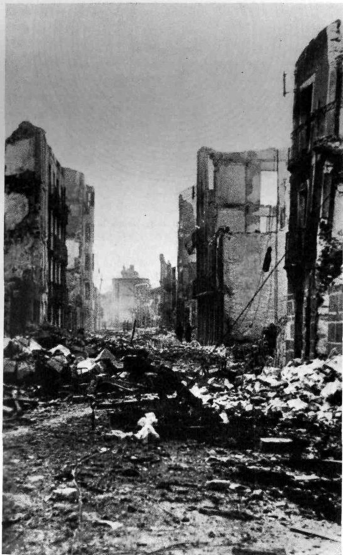
Zasute ceste v porušeni Guernici (26. aprila 1937.)
