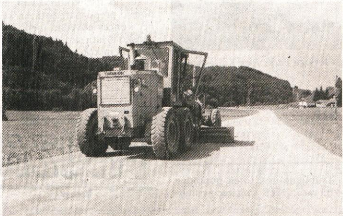
Na fotografiji: Še zadnja dela pred asfaltiranjem dela ceste med Horjulom in Dobrovo
