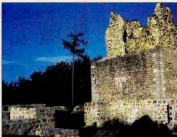
Na Starem gradu so letos nadaljevali obnovo zidov, želijo si obnoviti tudi razgledni stolp.
