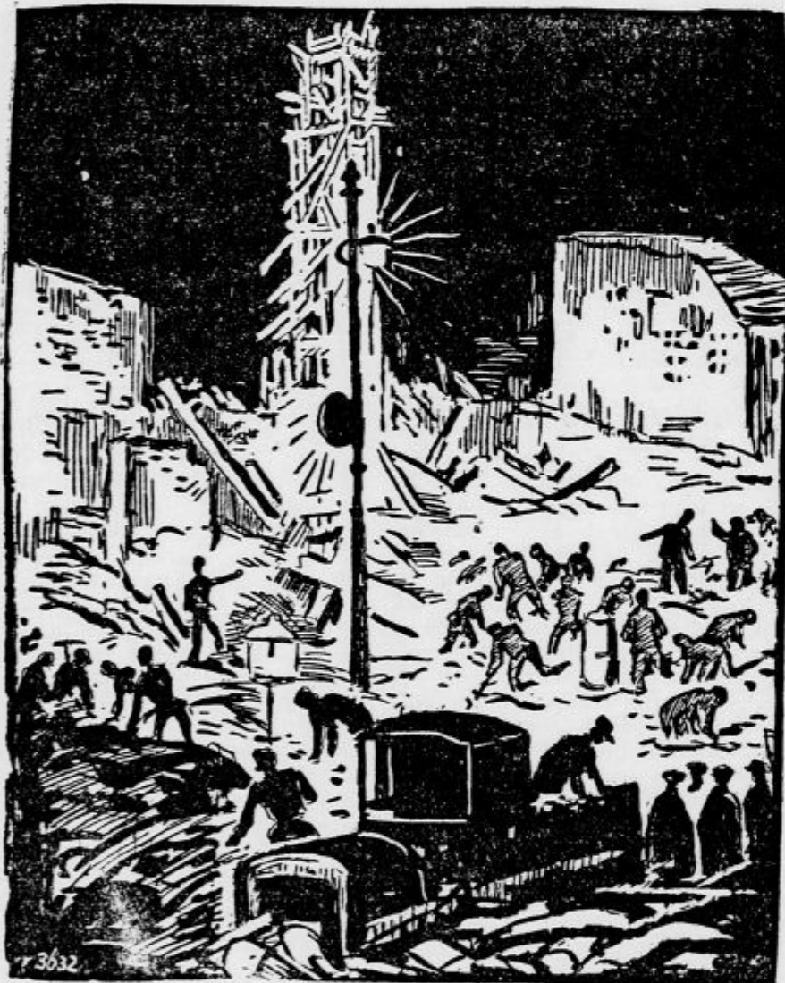
Pogled na stavbo, ki se je sesula
