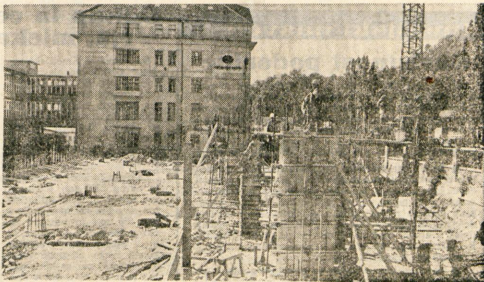
Gradnja centralnega skladišča tovarne Peko. — Foto: F. Perdan
