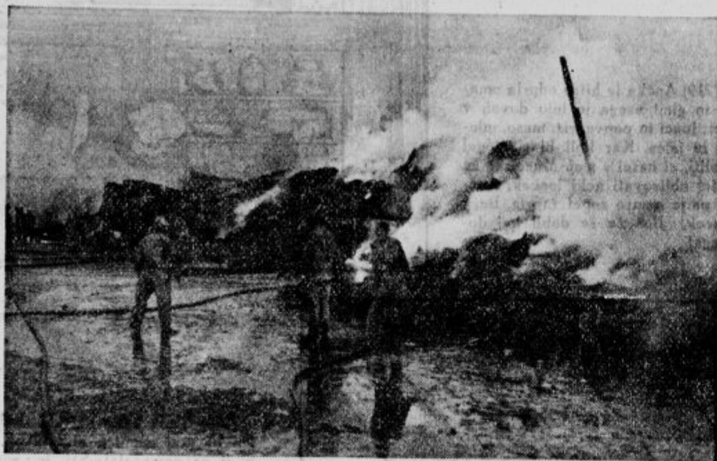
Pogled na pogorišče skladišča Bonačeve tovarne na Količevem. Na levo v ozadju zaradi dima se veda ni videti ogromnih skladov.
