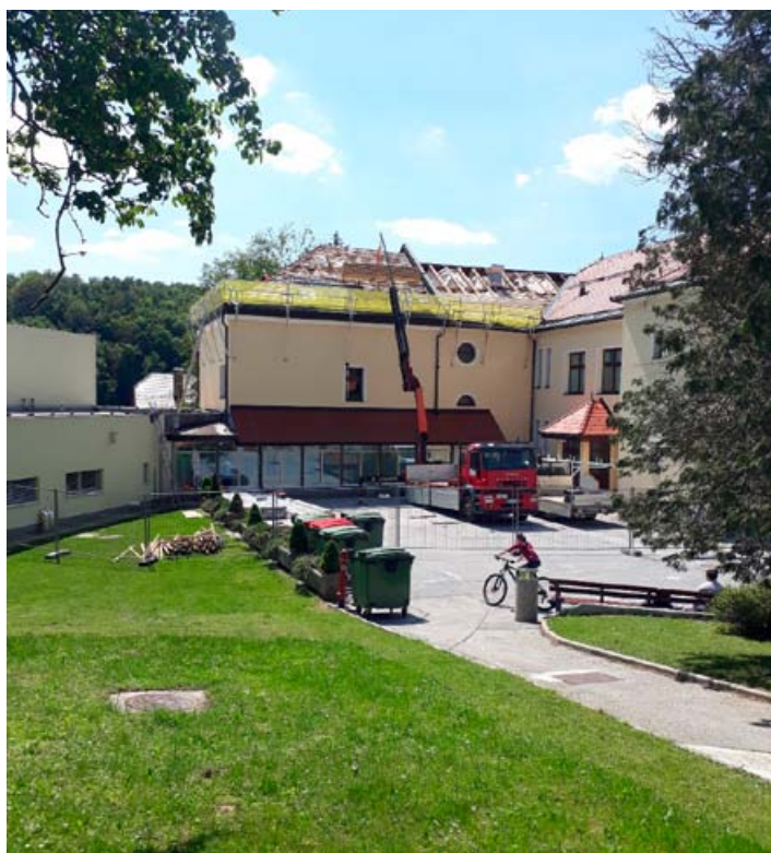
Obnova strehe OŠ
