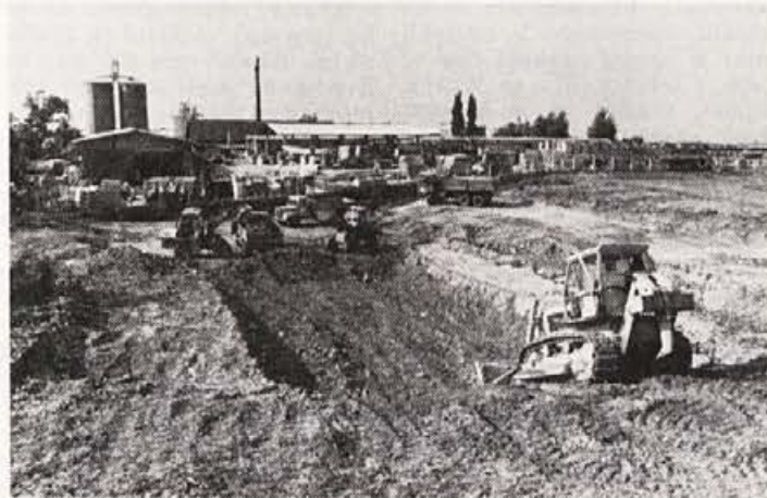
Začetek gradnje skladišča športnega orodja
