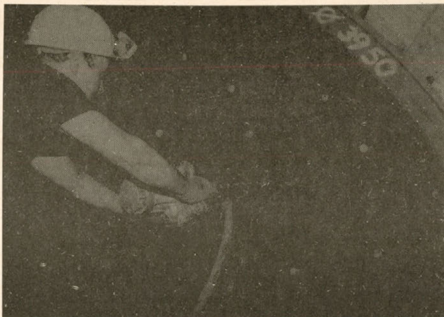
Iz arhiva Fotolaboratorija RLV: Priprave, j. Škale, marca 1990 - vrtanje za sidranje stene (Foto: Ivan Pungartnik)
