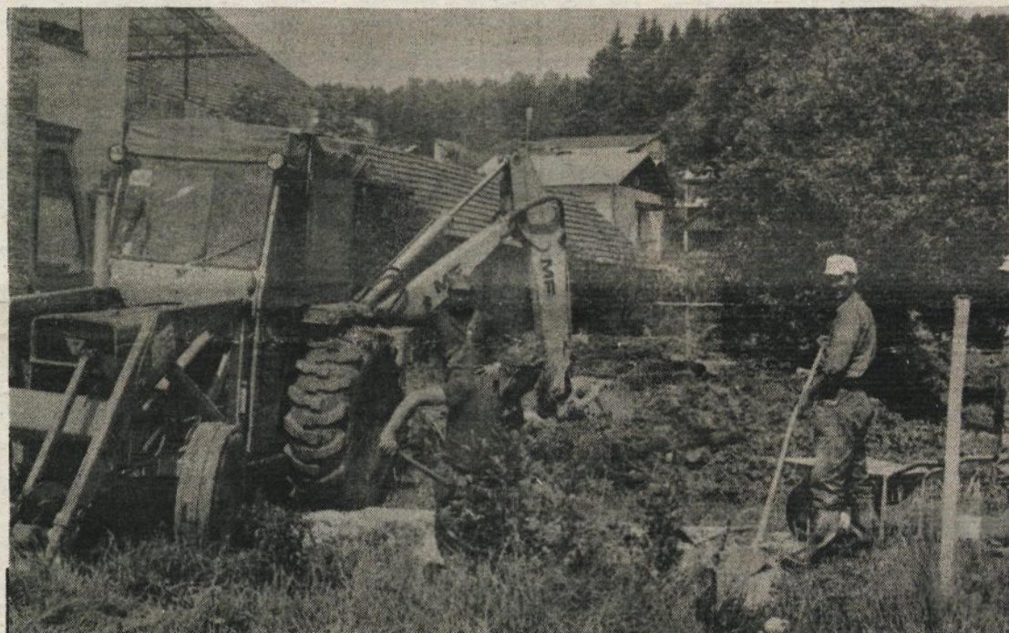
V Dragomeru in na Logu bo precej kanalizacijskega omrežja speljanega ob cestah in preko cest. Komunalno podjetje Vrhnika, ki je izvajalec del bo na teh mestih položilo kanalizacijske cevi, do začetka septembra, tako da bodo lahko začeli s pripravi za asfaltiranje.
