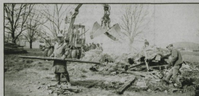
12 naših gasilcev je odstranjevalo dotrajan kozolec - topolar in sproti odvažalo material na odpad.
