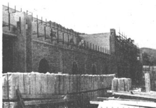
Kopalnice in garderobe za rudarje v izgradnji
