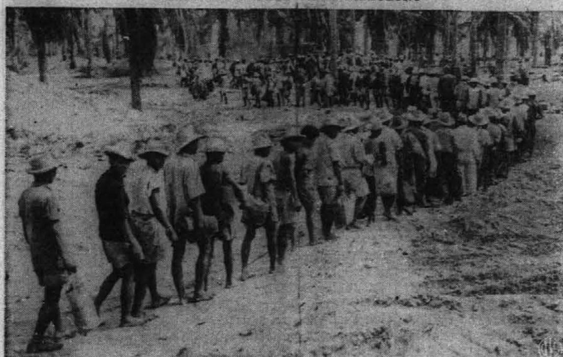
Dolga vrsta ima obliko črke "S", ko filipinski delavci prostovoljci nekje na otoku Luzon čakajo pod streho palmovih dreves na svojo dnevno opolnasko kosilo. Tle Filipinci pomagajo ameriški armadi postavljati barake in popravljati letališča, ko se velike luknjičaste kovinske plošče, s katerimi so potlakovana, kaj pokvarijo.
