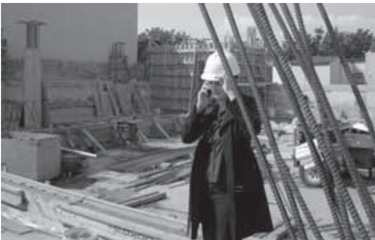
Gradbišče koncertne dvorane v Long Island Cityju, 2012. Ta čas največji projekt biroja Archipelagos in tudi eno izmed redkih aktivnih gradbišč v mestu.
