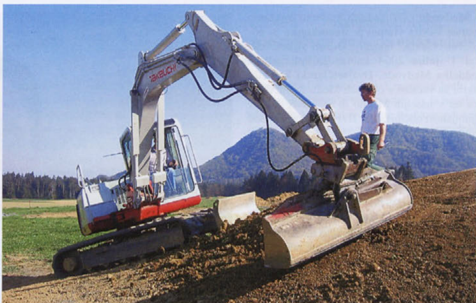
Golf igrišče Diners Club Ljubljana bo, kar se opreme tiče, najsodobnejše pri nas. Trenutno potekajo zemeljska dela.
