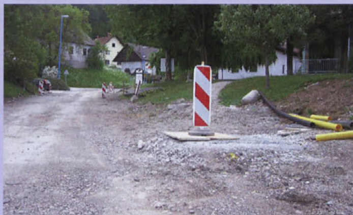
M. B. Gradnja kanalizacije v Sori poteka fazno. V teh dneh zaključujejo prvo fazo.
