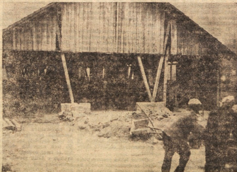
Dela pri urejanju hlevov na obratu Grmače KZ Litija
