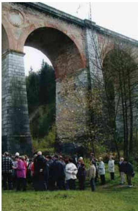
Ogled Dolinskega mostu
