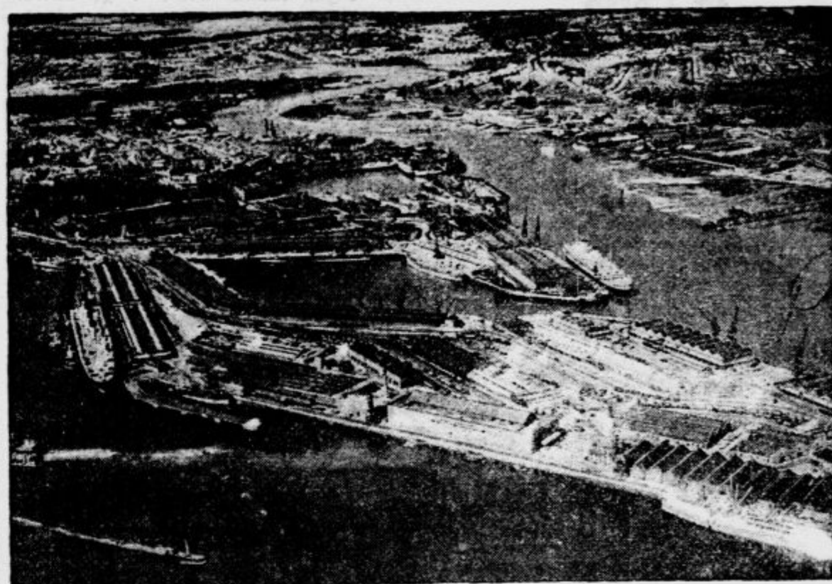
ki so ga nemški bombniki močno poškodovali
