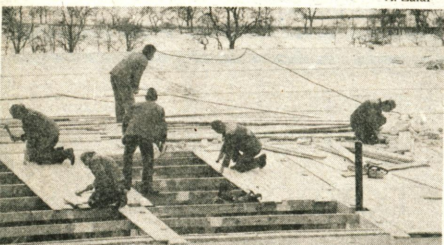
Begunje — Na strehi novega obrata plastike, ki ga je med vsemi objekti begunjskega Elana nedavno neurje najbolj poškodovano, so člani kolektiva v nedeljski prostovoljni akciji odstranili poškodovano kritino. Zatem so delavci SGP Grosuplje, ki je halo gradilo, zasilno pokrili stavbo, da je v njej spet možna proizvodnja. Preden bodo na stavbo postavili novo streho, bodo izbrali proti neurju bolj odporno kritino. (S) — Foto: S. Saje
