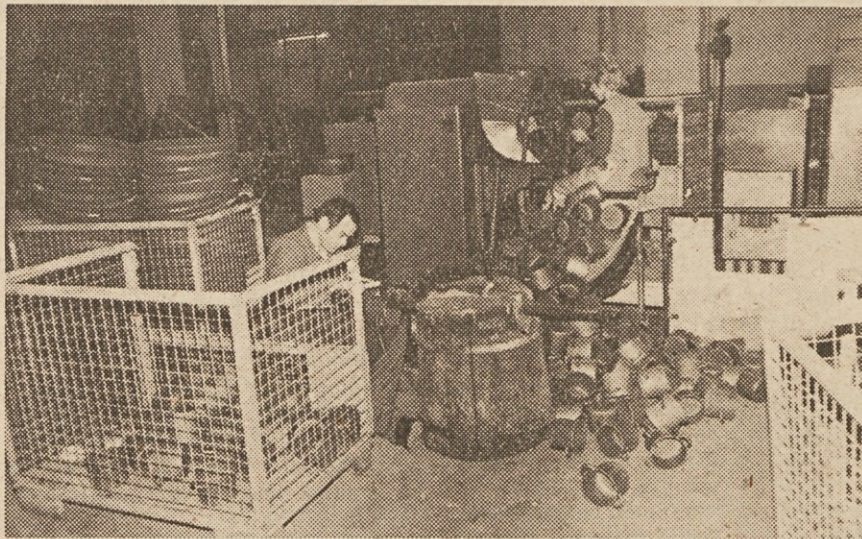
Stiskalnice pri izdelavi surove posode marsikaj „zagrešijo“, vendar tu je poseben oddelek, v katerem delavci ročno popravijo vse te „grehe“.
