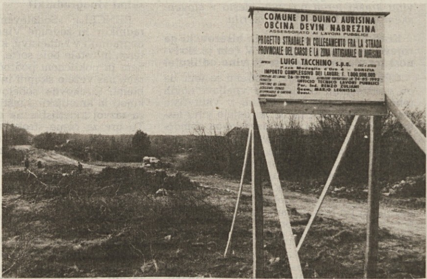
Gradbišče obrtniške cone
