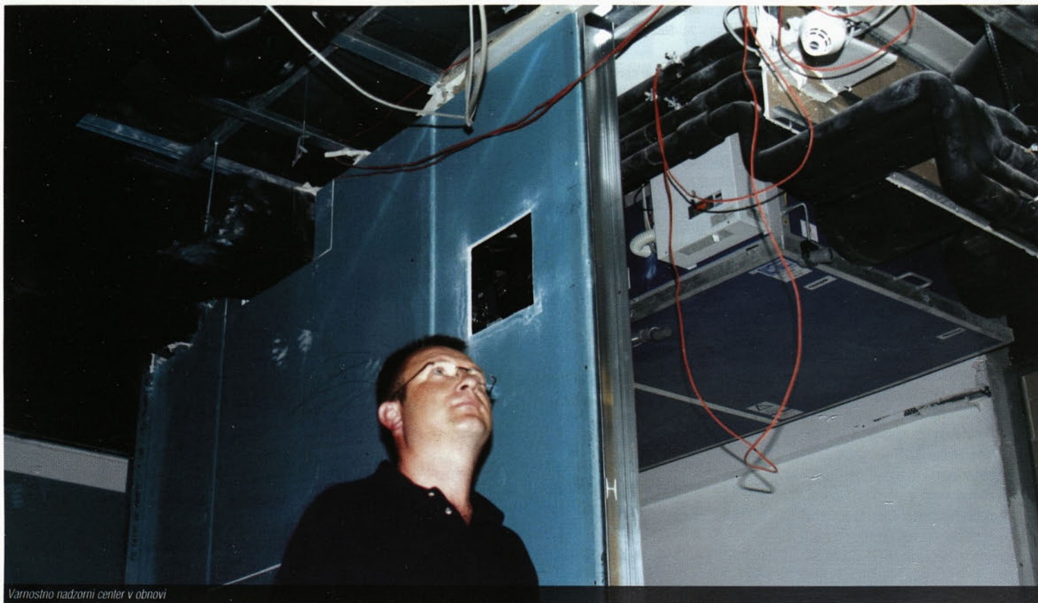
Varnostno nadzorni center v obnovi
