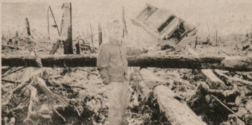
Guverner Severne Caroline Jim Hunt ob razdejajanju, ki ga je povzročil tornado. Moč vetra je bila tako silovita, da je zakoličila težko dostavno vozilo na drevesne štoré (Telefoto AP)
