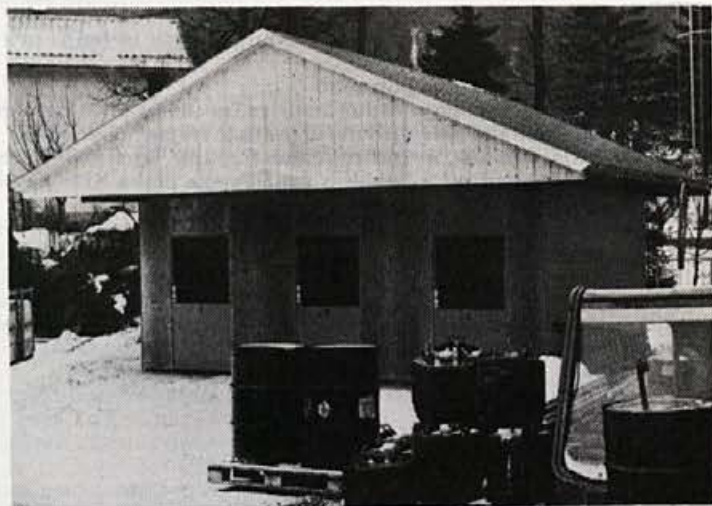
Novo skladišče plina
