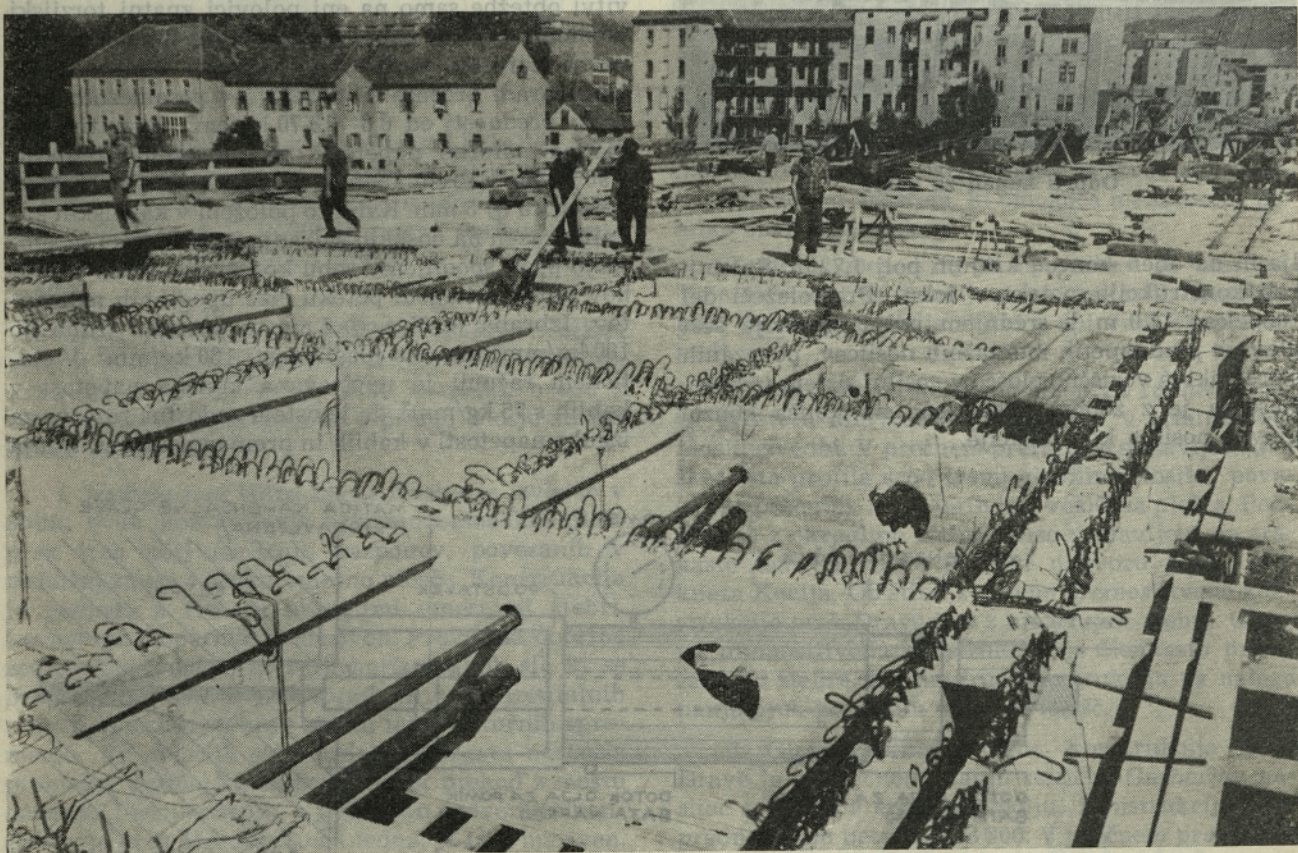
Glavni in prečni nosilci rešetke pred opaženjem voziščne plošče
