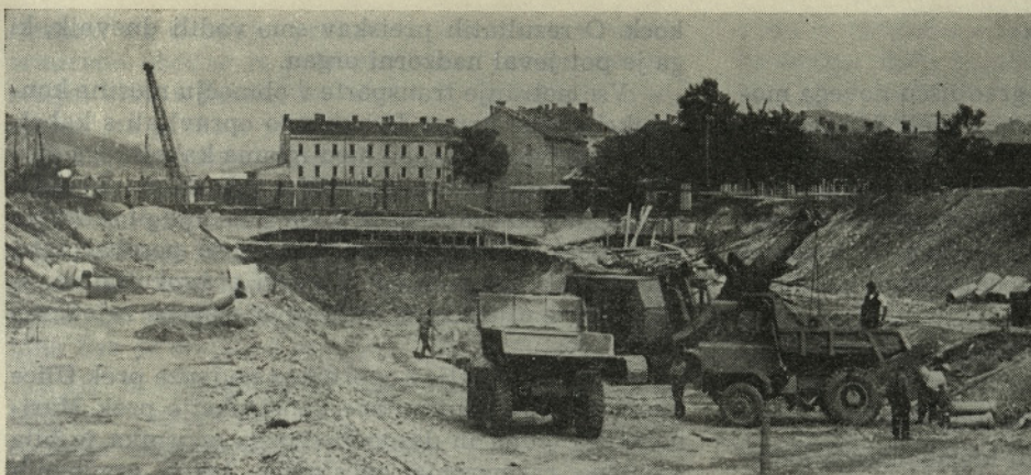
Mehaniziran izkop pod železniškimi podvozji
