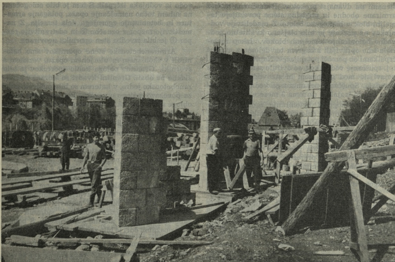
Priprava granitne obloge konic rečnih opornikov
