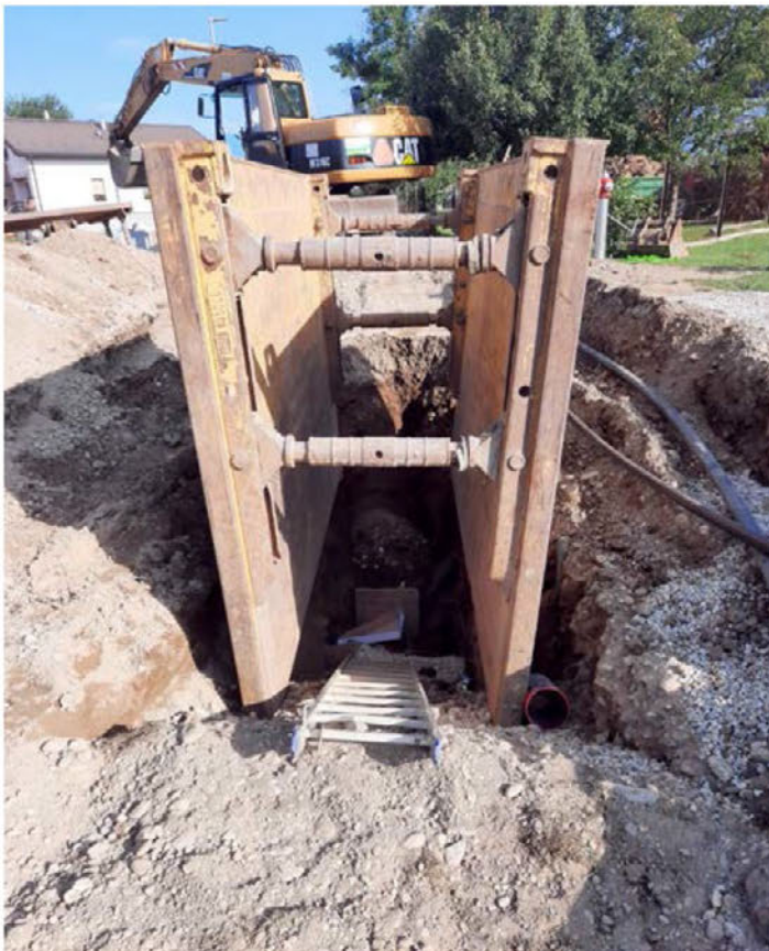
Dela na kanalizacijskem sistemu v Lancovi vasi od avtocestnega odseka so v polnem teku.
