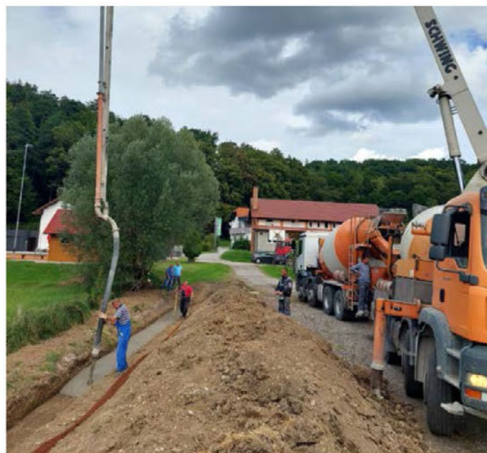
Gradbena dela za zunanje prizorišče pri Domu krajanov Dolena
