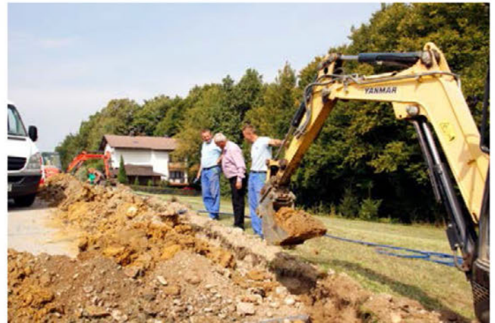
V KS Soviče - Dravci - Vareja je v izvedbi modernizacija vodovodnega sistema
