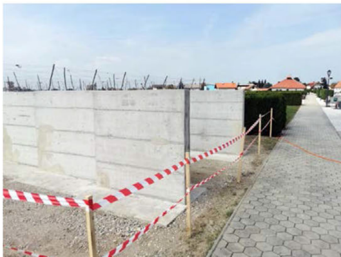
Na pokopališču Videm je v izgradnji žarni zid. Foto: arhiv občinske uprave, TM, Rado Škrjanec
