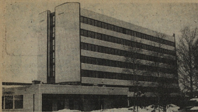
Razvojno tehnološki center novih Kovinskih obratov Ljubljana
