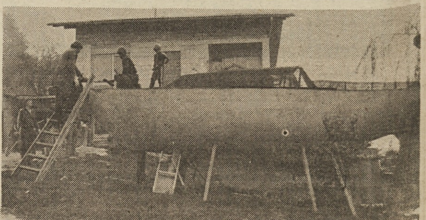
TOZD ELEKTROLITSKI KONDENZATORJI MOKRONOG: Zdene Schmautz, tehnik v razvoju, je v soboto, 14. oktobra s kolegi betoniral svojo jadrnico. Porabil je načrt prof. Jereba, je pa po lastni zamisli načrte precej izpopolnil. Ladja bo dolga 8 metrov, imela bo dva motorja: glavnega z 12 KM in pomožnega za občasno pomoč z 10 KM. Tako bo jahta zmogla kakih 7 morskih milj na uro, ali 14 km.
