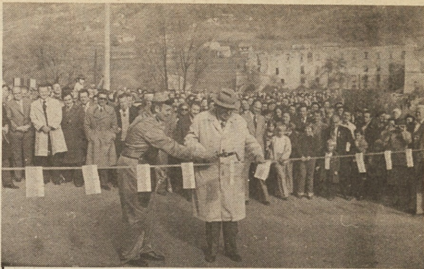
V Soteski je v nedeljo 29. oktobra Franc Leskošek Luka z varilnim aparatom prekinil jekleno vrstico in tako odprl pomembno asfaltno cesto -Partizansko magistralo od Soteske do Adlešičev, katere novi odsek v dolžini skoraj 18 kilometrov so dogradili letos. Slavnost se je nadaljevala z zborovanjem v Kotu pri Semiču, kjer je bil slavnostni govornik Janez Vipotnik, predsednik RO ZZB NOV Slovenije.
