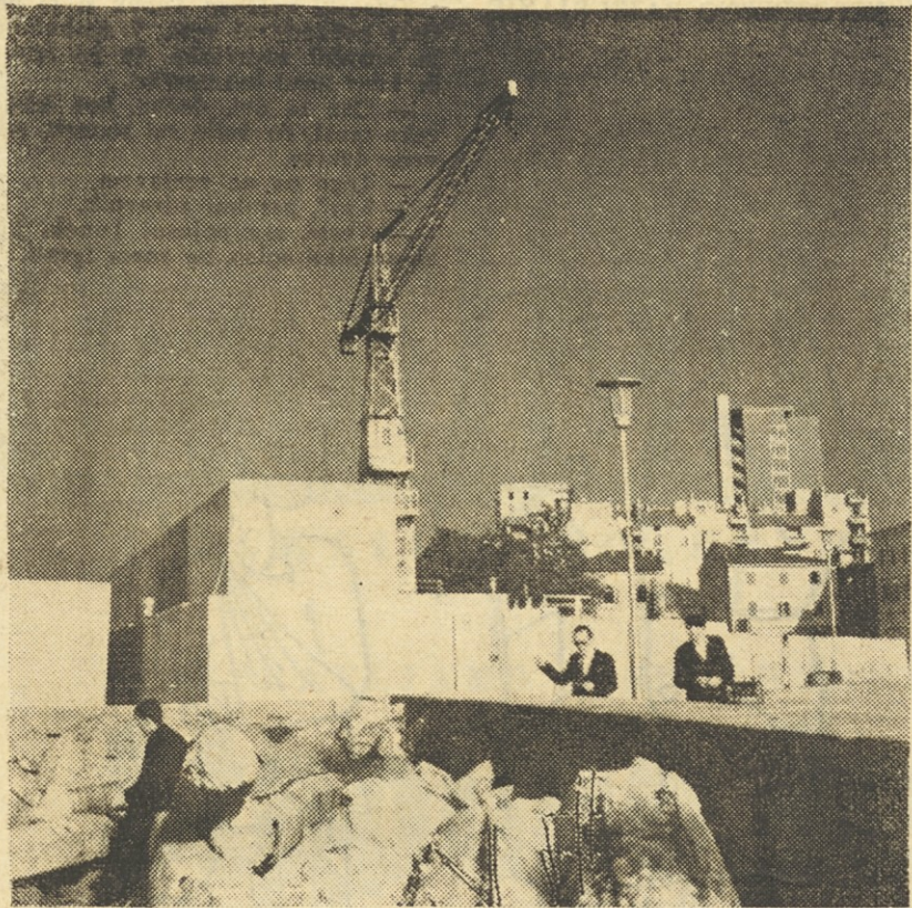
Stotonski betonski skladi čakajo, da jih bo »Veli Jože« prepeljal na gradbišče
