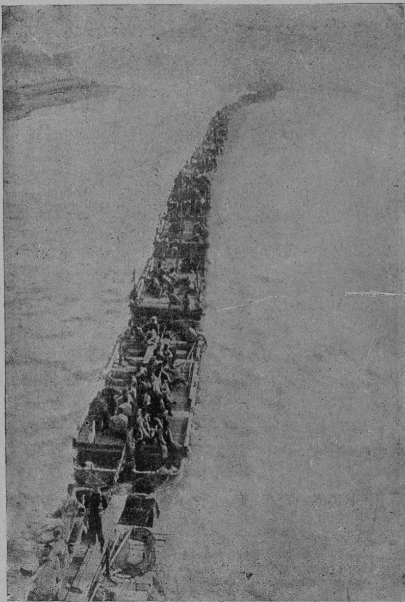
Plavajoč most pri Solunu. Za hitrejšo prevažanje in izkrcavanje vojaštva so sestavili francoski pionirji iz čolnov most, na katerega nakladajo moštvo in blago na visokem morju in katerega potem posebni parniki zavlečejo do obali. Solunska luka je namreč tako prenapolnjena raznih ladij in parnikov, da morajo velike ladje ostajati zunaj na odprtem morju.
